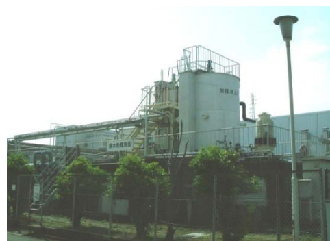
搔寄機更新(鶴見工場)
