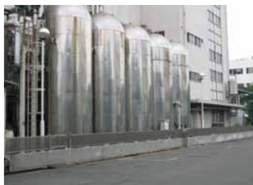
屋外タンク防液堤（鶴見工場）
