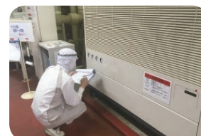
空調機点検の様子
