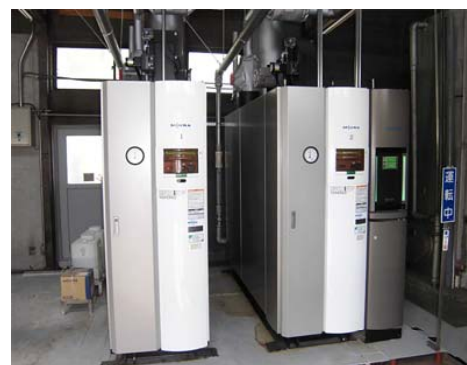
都市ガス燃料ボイラー（森永甲府フーズ）
