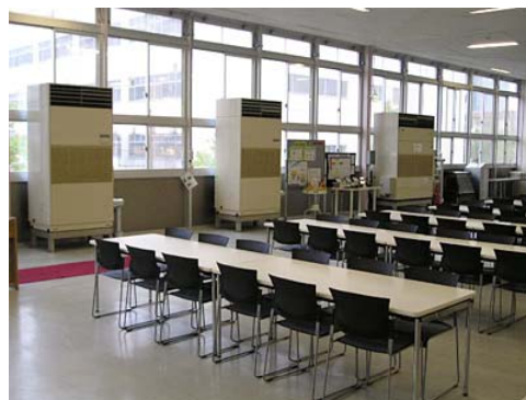
遮熱シート取り付け(鶴見工場)
