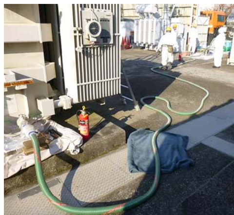
低濃度PCB汚染油抜油風景(鶴見工場)
