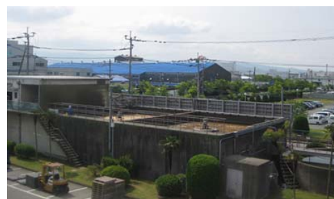
排水処理設備(森永デザート)
