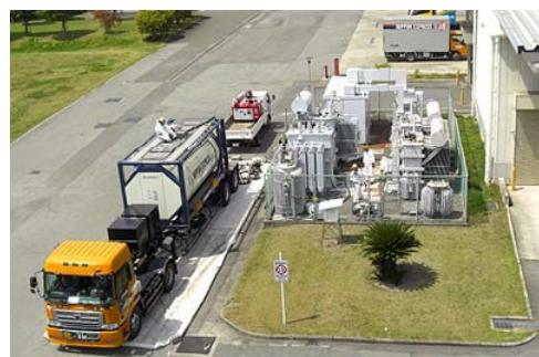
PCB抜油、積込み風景(塚口工場)
