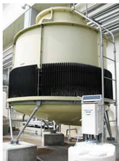
ソーラーパネル電源(中京工場)
